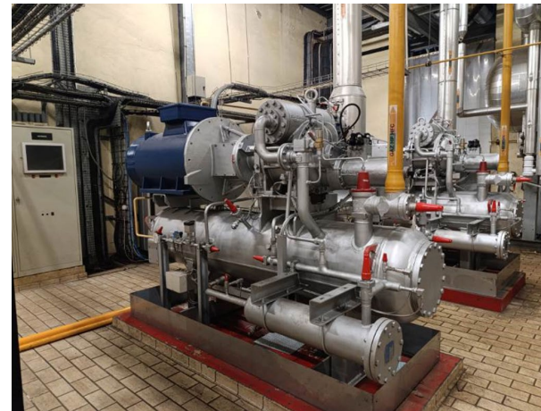
Salle des machines Compresseurs R134a
